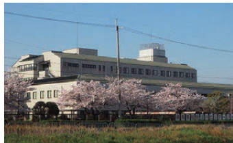
奈良県総合リハビリテーションセンター
